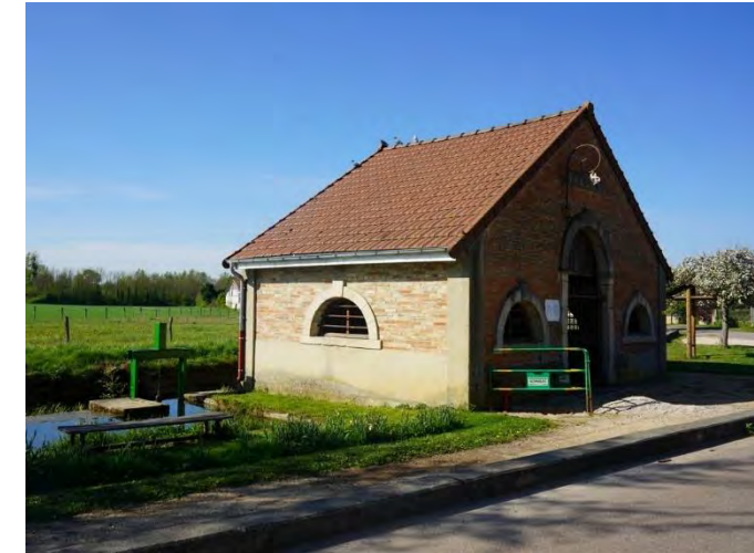
Figure 227 : Le lavoir à Sapignicourt
