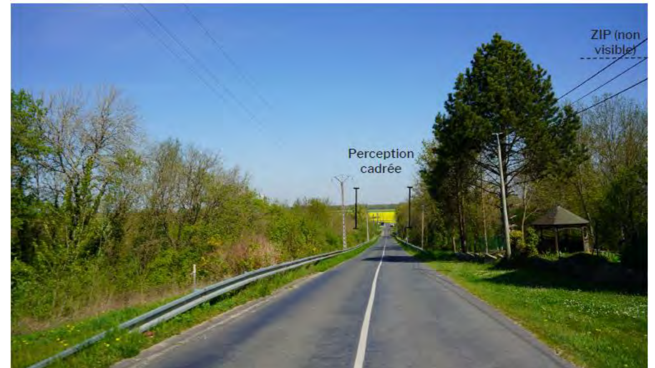
Figure 215 : Traversée de la vallée de la Marne à Hauteville
